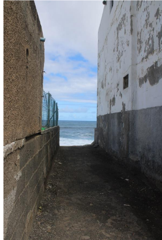
Figura 13. Acceso junto a estación de bombeo Fuente: Elaboración propia
